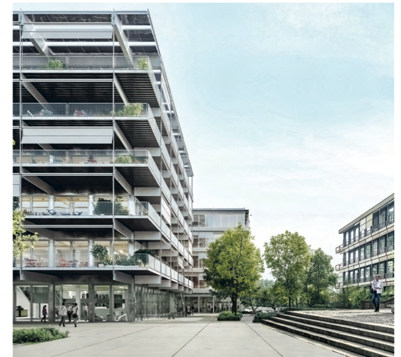
Blick von der «Magistrale» auf die zwei Neubauten
