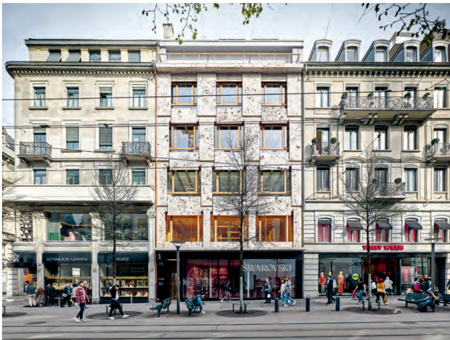
Nach oben verjüngend: die Fenster in der Tuffsteinfassade der Bahnhofstrasse 78 in Zürich.
