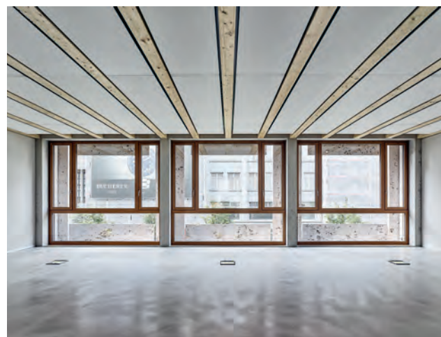
Der poröse Tuffstein wirkt als Filter vor den grossen Fensterflächen.
