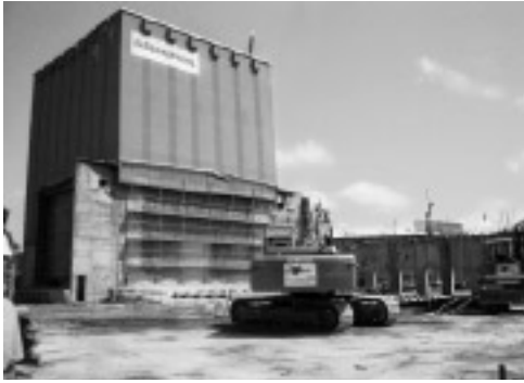
EM2N, Theater 11 , Zürich, freigestellter Bühnenturm des Vorgängerbaus
