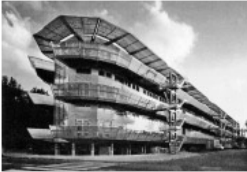
Jean Nouvel, Wohnanlage Nemausus, Nîmes, 1986
