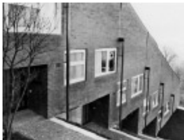
Claude Paillard, Terrassen- haus Eierbrechtstrasse , Zürich, 1959
